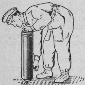
Рис. 20. Приведение огнетушителя ОП-3 в действие
